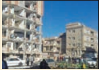
یکی از ساختمان‌ها مسکن مهر و دیگری ساختمان عادی می‌باشد!
